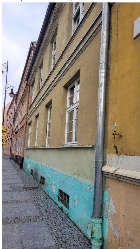
Uszkodzony tynk w strefie cokołowej oraz powyżej.
